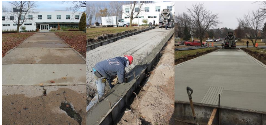
Figure 3 Illustration de la coulée pilote de l'allée piétonnière en béton de 17 m 3 avec l'ancienne allée à gauche, la coulée au centre et le trottoir frais à droite.
